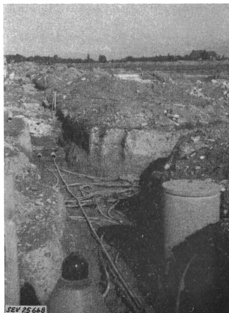
Fig. 6 Prolongation de la piste, côté N-E Terrassement pour câbles; à droite, un puits en ciment pour feu de piste
