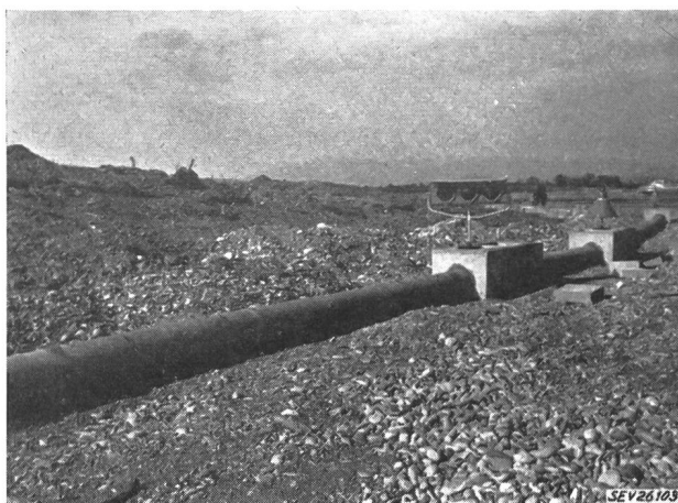
Fig. 3 Zementrohrleitung mit Lampenkasten Rechts eine Pistensperlleuchte mit einer grünen und zwei roten Lampen
