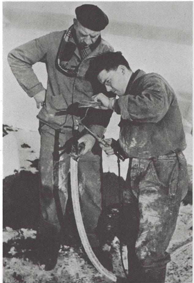
Fig. 25 Montage d'un câble
