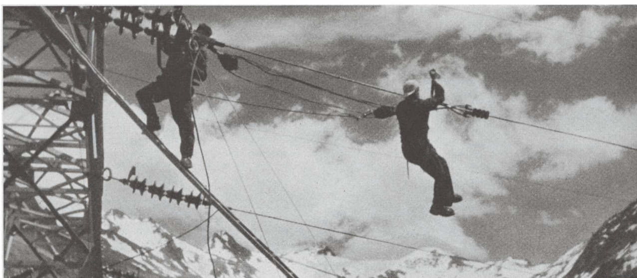
Fig. 19 Travaux d'entretien sur la ligne franchissant le St-Gothard
