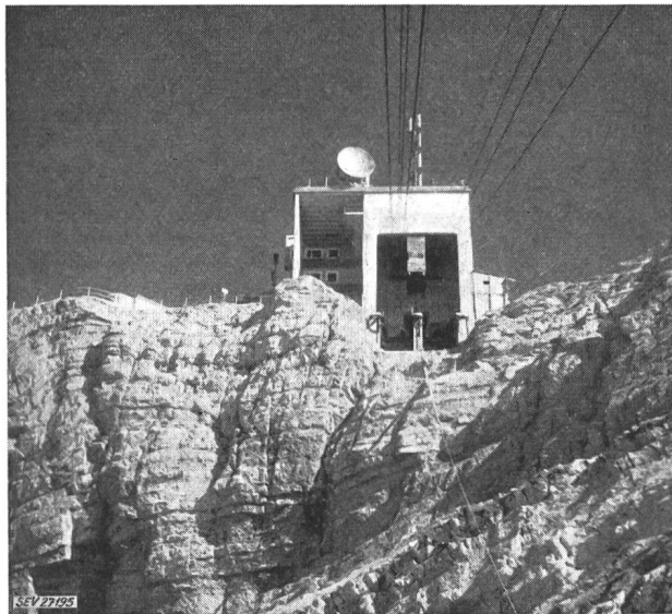
Fig. 1 Mehrzweckanlage der PTT, an der Bergstation der Säntis-Schwebebahn angebaut
