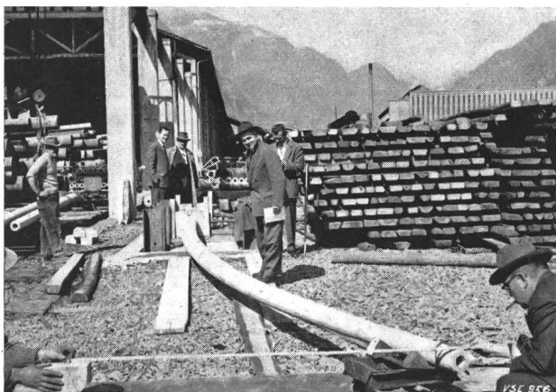
Fig. 3 Essai à la flexion d'un support en béton long de 10 m (longueur libre 8,5 m)
