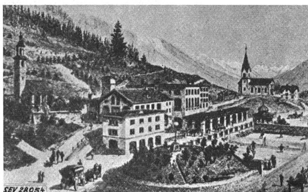
Fig. 2 Die im Jahre 1881 errichtete Bogenlampe vor dem Kulm-Hotel
