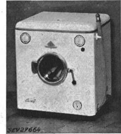
Cette machine à laver le linge a subi avec succès les essais relatifs à la sécurité. Elle est conforme au «Règlement pour l'octroi du signe distinctif antiparasite» (Publ. n° 117 f). Utilisation: dans des locaux mouillés. Raccordement à demeure et non par dispositif de connexion à fiches.
