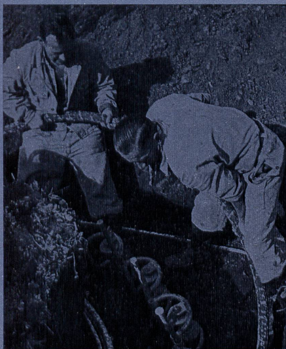
⑤ Remplacement d'un câble à basse tension
