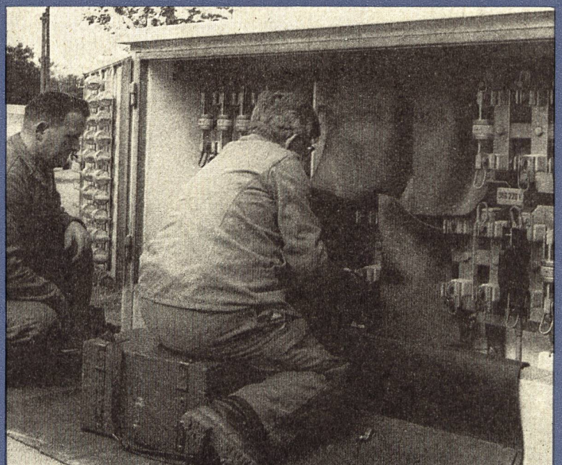
❹ Dépannage d'un coffret de distribution
