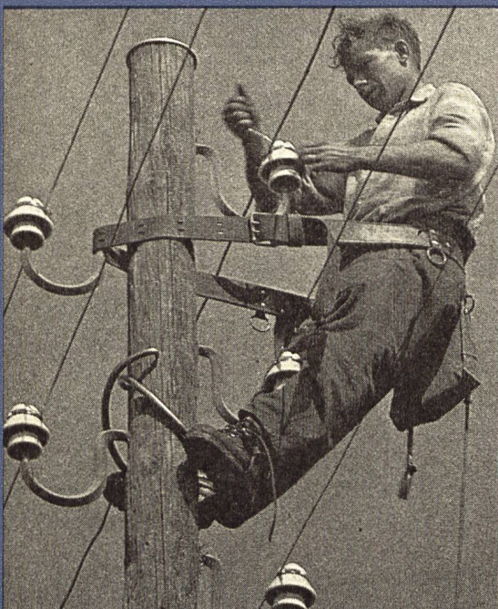
❸ Travail sur une ligne à 16 kV
