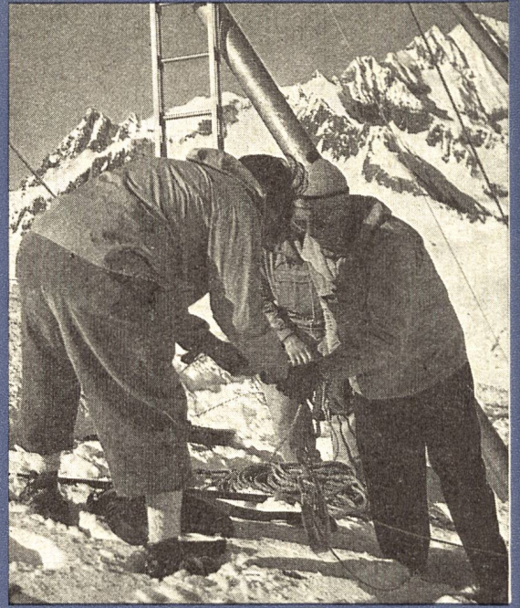
❷ Réparation d'une ligne à haute tension en montagne
