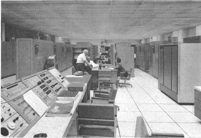
Fig. 2 Beleuchtung eines Computerraumes mit Fluoreszenzlicht
