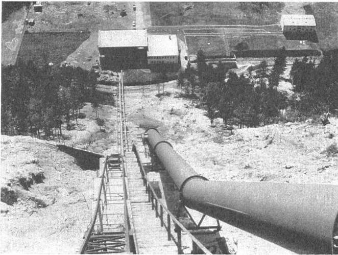
Fig. 7 Das Diessbachwerk mit vorerst einer Druckrohrleitung
