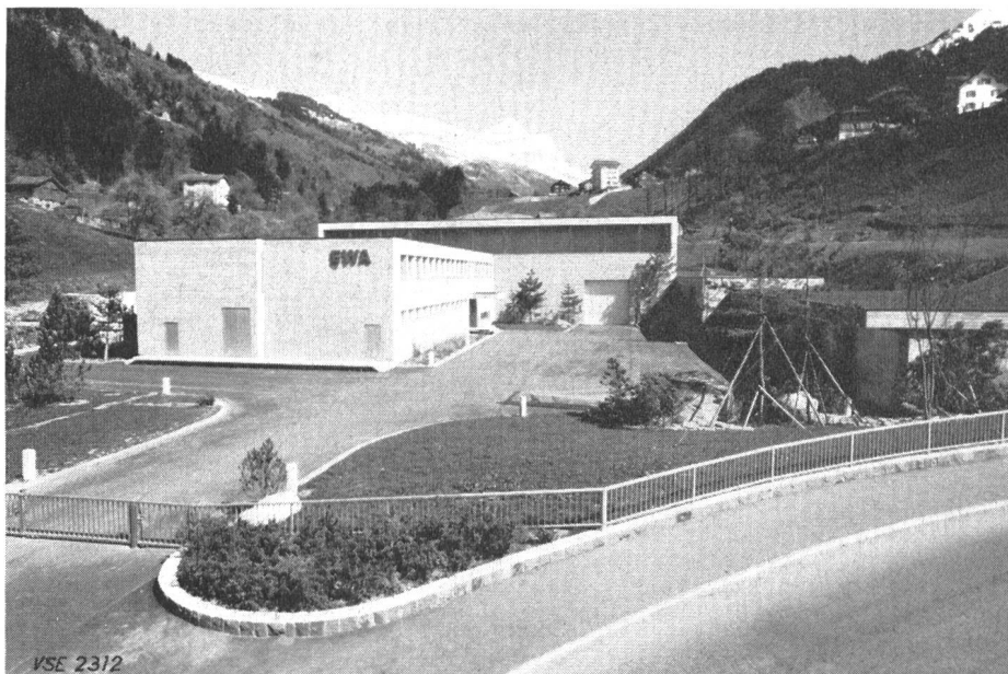
Fig. 2 Centrale de Bürklen
