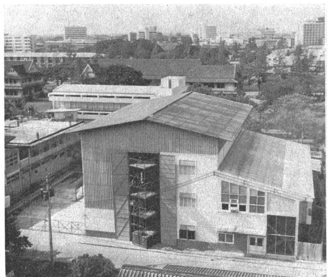
Fig. 6 Ansicht des Laboratoriums von Norden
