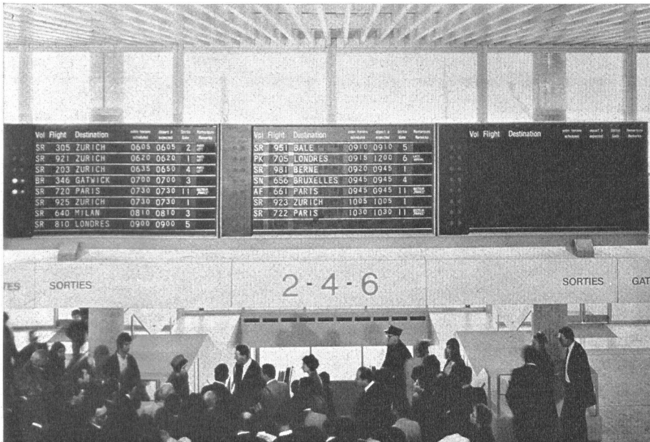
Fig. 10 Anzeigetafeln mit Einzelanzeigegeräten für Buchstaben, Zahlen sowie Buchstaben plus Zahlen und gleich raschen Breitpalettenmel- dern für stereotype Hinweise
