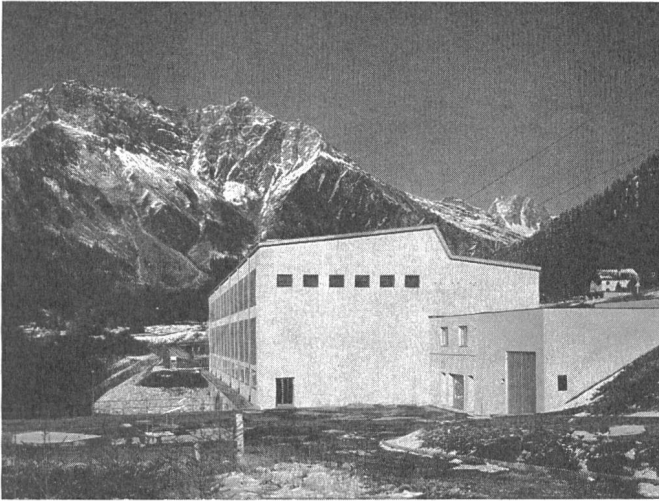
Fig. 3 Ansicht des Kraftwerkes Löbbia, rechts mit dem neuen Gebäude für die Speicherpumpe
