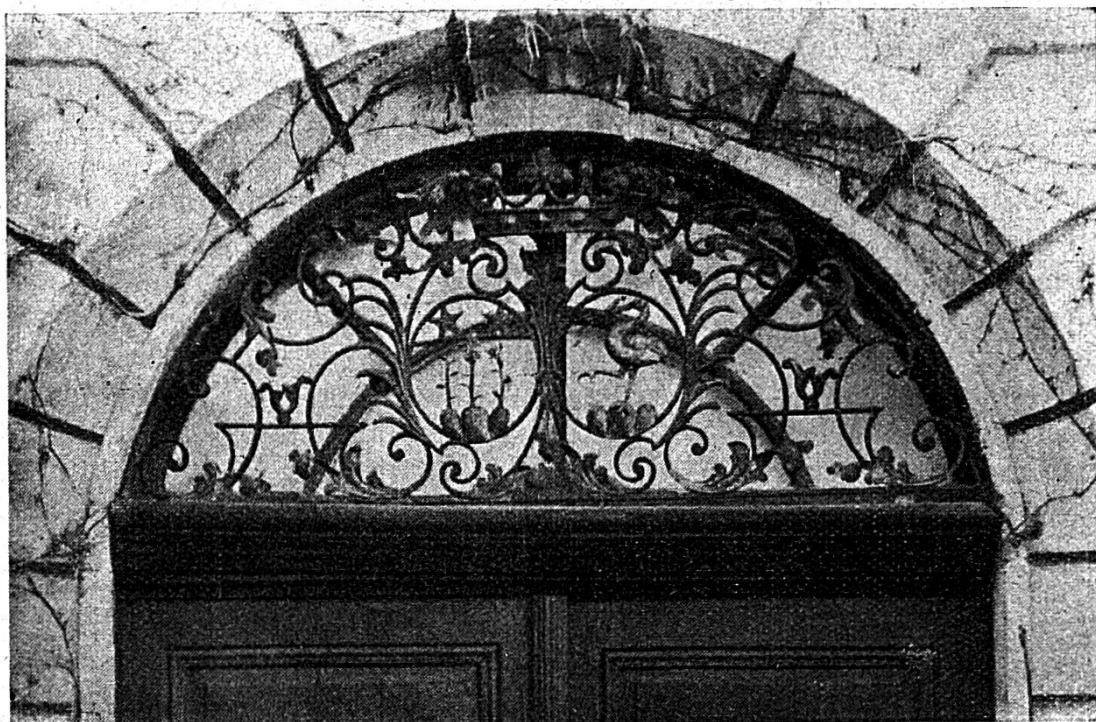
Grillage surmontant la porte d'entrée de la maison Alfred Ceppi et montrant les armoiries accolées des de Billieux et des Tardy.
