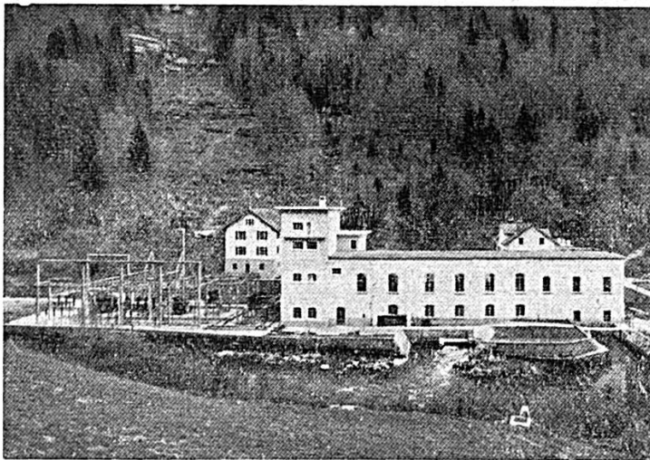
Usine de la Goule sur le Doubs
