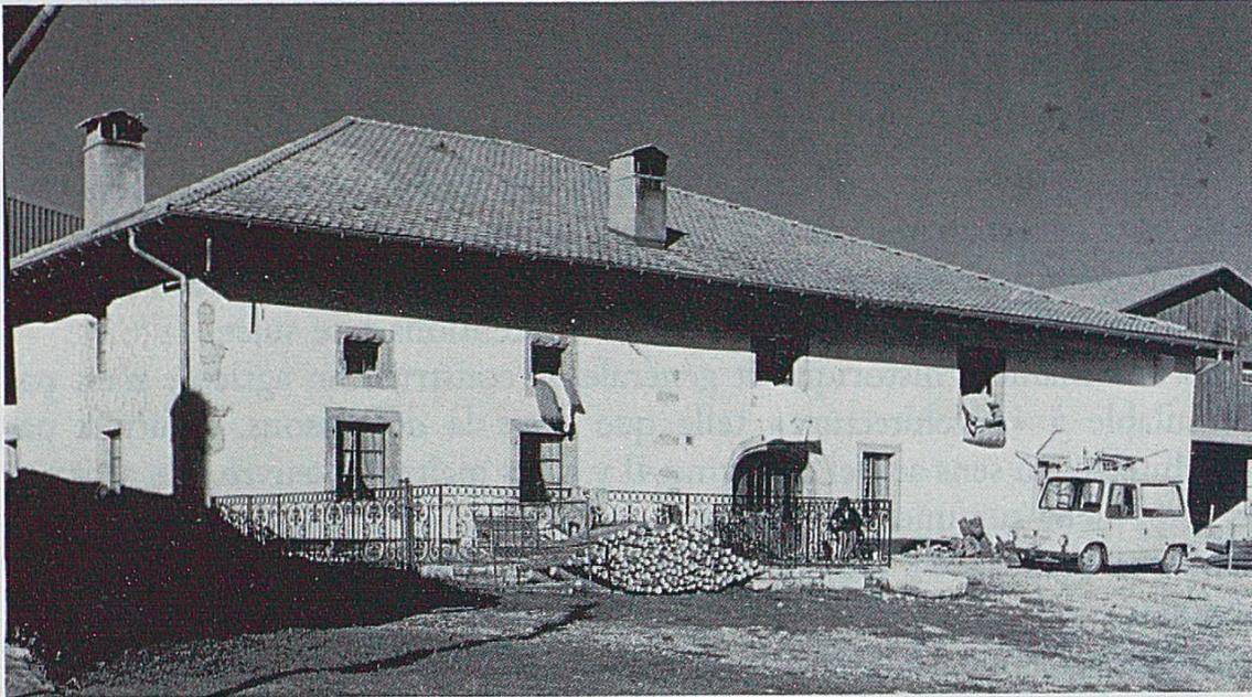
La maison typique, représentée sur les cartes postales, avec toit à deux pans et pont de grange auréolé d'une porte cintrée est, en effet, l'une des formes typiques de la ferme franc-montagnarde. Cependant, on peut admettre actuellement que la première forme de construction que l'on connut ici fut la ferme à quatre pans.
