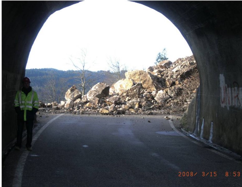
Figure 3: l'accumulation des 200 m 3 de blocs calcaires sur la H18 (vue vers l'ouest depuis l'intérieur du tunnel de la Roche).
