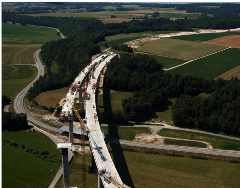
Fig. 1: Vue aérienne, en direction du nord, sur le tracé de l'autoroute A16 entre le viaduc du Creugenat et le tunnel de Bure, communes de Courtedoux et Chevenez.
