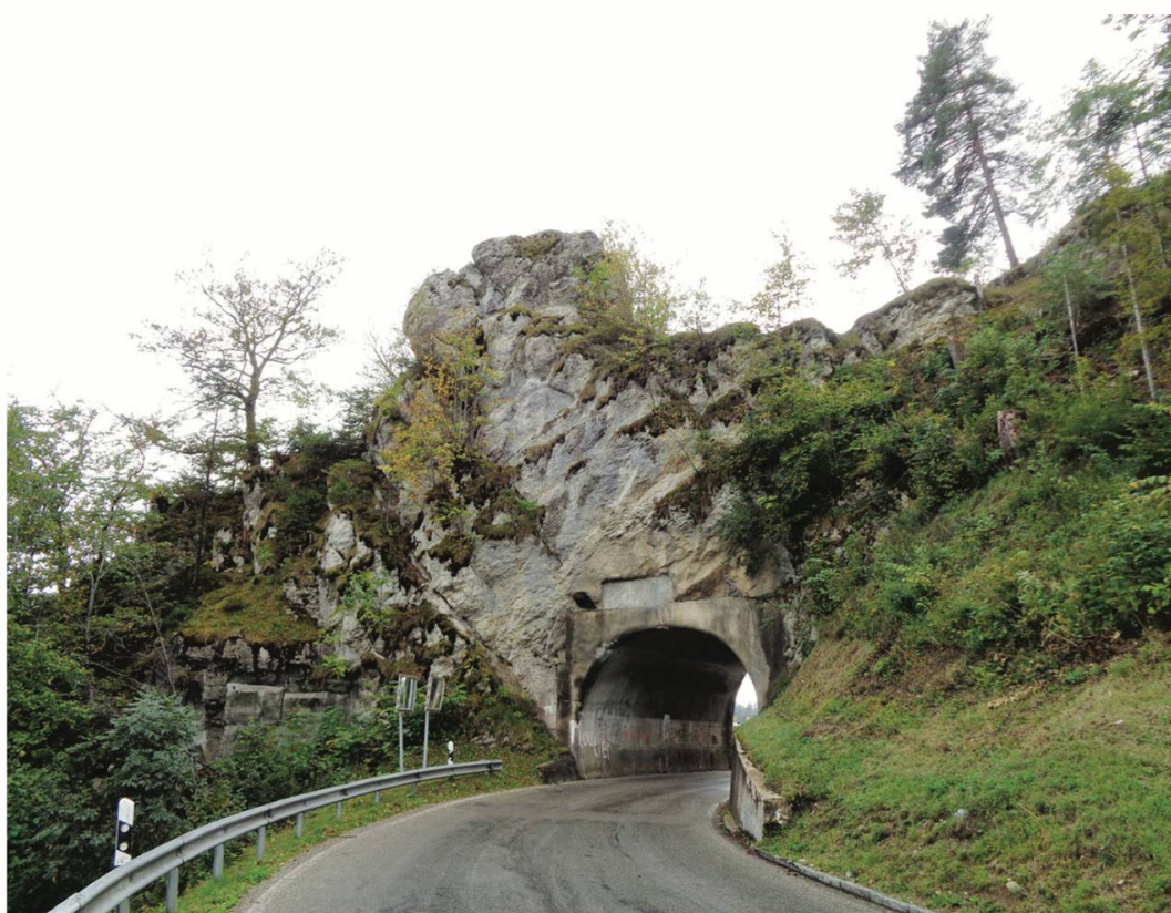
Fig. 5 : La porte de la Montagne (tunnel de la Roche), entre Glovelier et Saint-Brais. Suite à l'élargissement et au bétonnage du passage en 1927, l'inscription commémorative n'est plus dans l'axe de la voûte. Photo Marc Lambelet.
