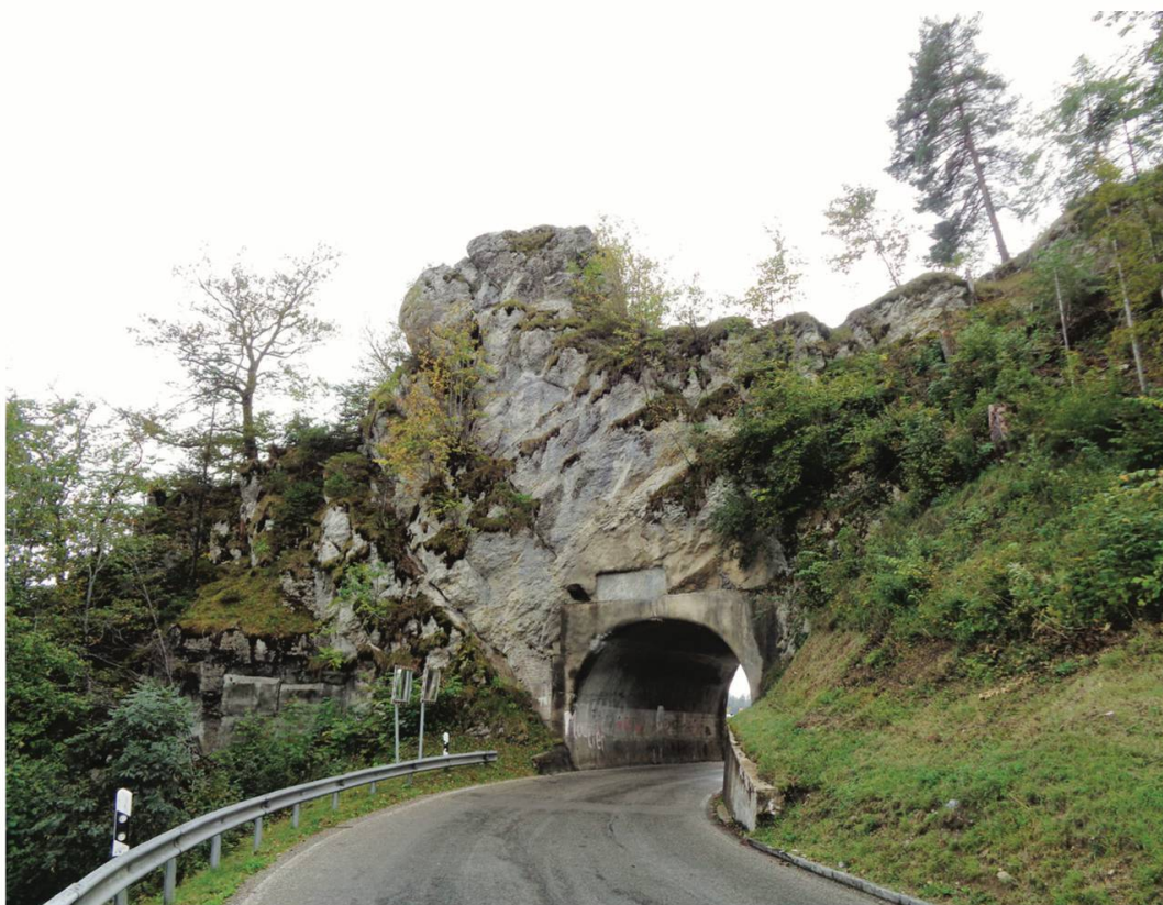
Fig. 5 : La porte de la Montagne (tunnel de la Roche), entre Glovelier et Saint-Brais. Suite à l'élargissement et au bétonnage du passage en 1927, l'inscription commémorative n'est plus dans l'axe de la voûte. Photo Marc Lambelet.
