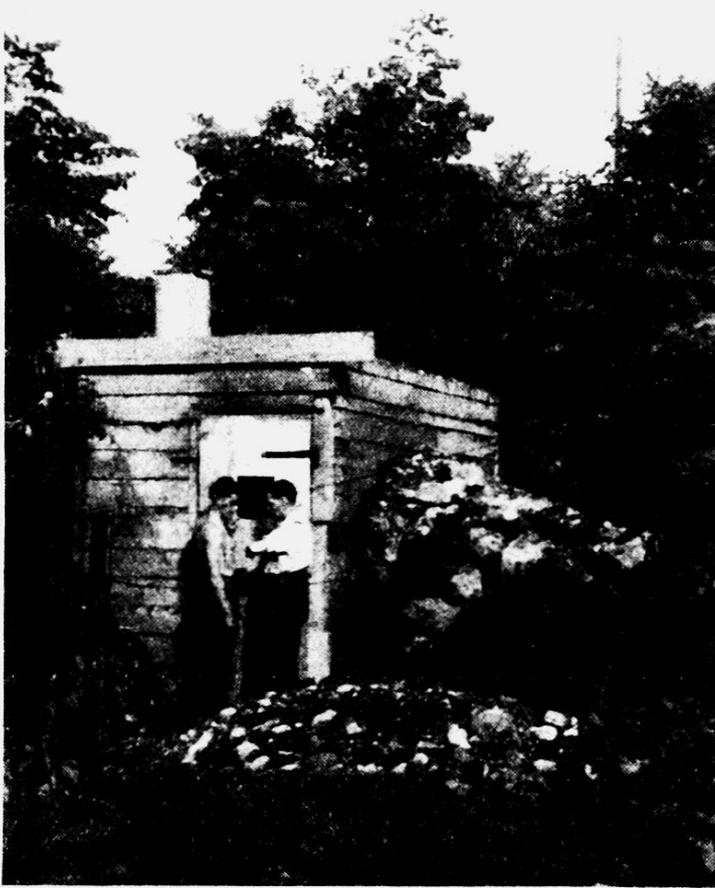
hauses: 4 m lang, 2 m breit, 2,5 m hoch. Drei Zimmerleute aus dem Bat. San. Z. besorgten in einer mechanischen Zimmerei des nahen Städtchens in zweitägiger Arbeit die Zurichtung des Holzes. In 2 Rahmen aus 20 cm starken Gerüstbalken wurden die 10 cm dicken Flecklinge eingelassen und mit einer Zwischenschicht von trockenem Moos gut gegeneinander abgedichtet. Als Decke eine einfache Lage von Flecklingen gleicher Dicke. In der Vorderwand seitlich eine Türe von 60 cm Breite mit Fenster im
