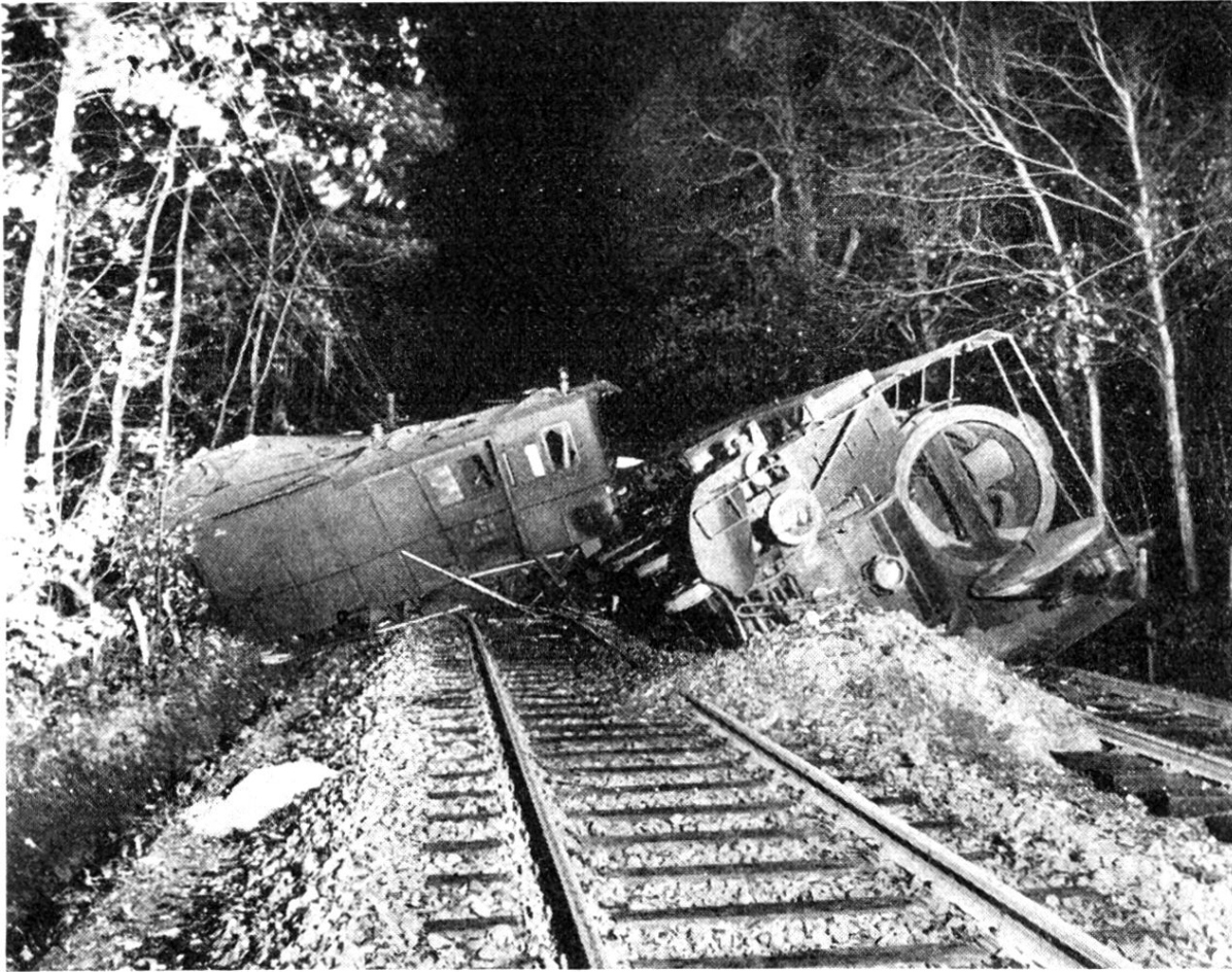
Auswirkung einer Geleisesprengung bei Espergaerde im November 1942
