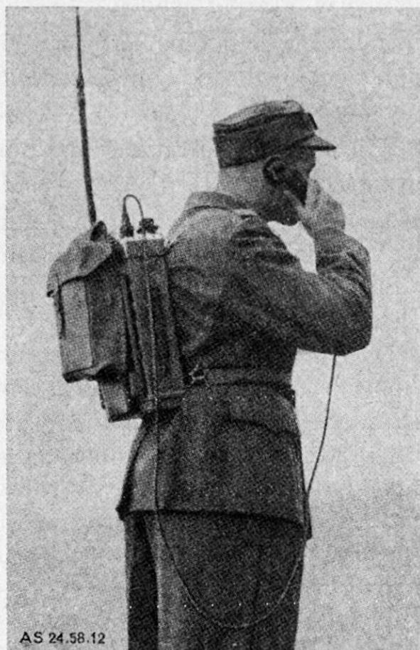
4 Stunden Arbeit pro Tag. Das Gewicht des kompletten Kleinfunkgerätes beträgt 11,3 kg. Die Speisung des Kleinfunkgerätes kann auch durch den *Handgenerator* erfolgen. Mittels Handgenerator wird gegenüber dem Trockenbatteriebetrieb eine dreimal größere Sendeleistung erzeugt.
