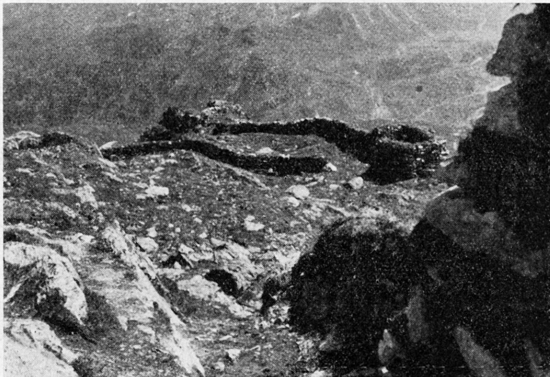
Stützpunkt, Geländeverstärkung auf Felsboden aufgebaut
