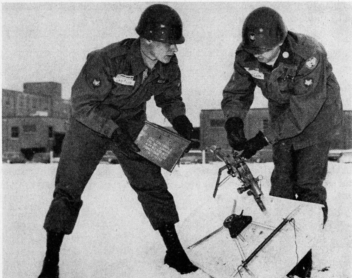
Abgesehen von der einfachen Konstruktion hat das «Ahkio-Maschinengewehr» manch andere Vorteile. Es ist leicht zu verschieben, auf dem Schlitten können Ausrüstungsgegenstände und Munition transportiert werden, und die Zeit für den Stellungsbezug im hohen Schnee wird auf ein erträgliches Maß reduziert («Infantry», Mai 1960). PR
