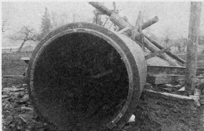
Bild 12. Blick in Fuchsröhre mit Trümmeranfüllung.
