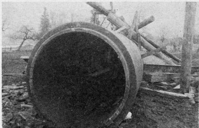
Bild 12. Blick in Fuchsröhre mit Trümmeranfüllung.
