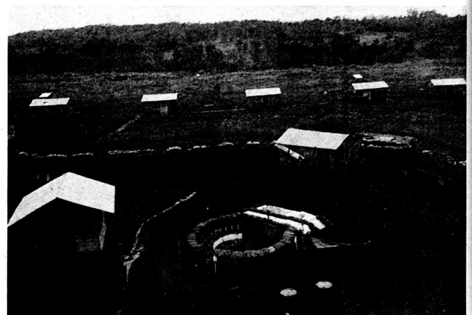
Bild 5. Südostecke des Camps von Duc-Co.
