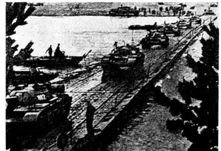
Bild 3. Die fertige Pontonbrücke PMP (150 m lang).
