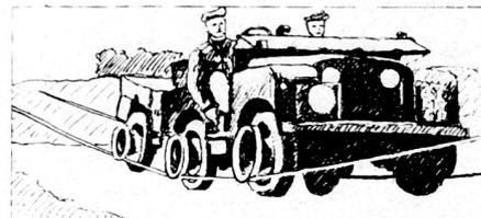
seile wurden als Spurbahn verlegt. An die Radnaben von leichten Fahrzeugen montierte man Profilscheiben (ähnlich den Keilriemenscheiben), mit denen die Seile befahren werden können.
