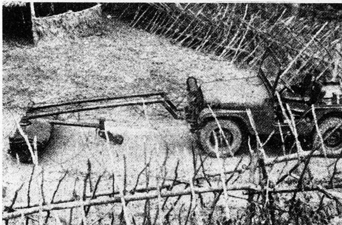
Bild 2. Am Jeep angebautes Minensuchgerät, auch fernzusteuern.
