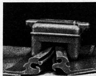
Bild 2. Prinzip des Verschlusses nach dem Driclad-System.
