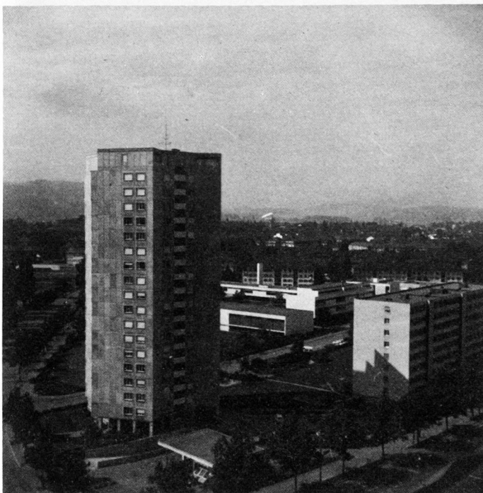
Bild 26. Stützpunkt Hochhäuser. Ansicht des Hochhauses A, Blick auf die Nordostfassade. Standort des Photographen auf der Dachterrasse des Hochhauses B. Das Hochhaus A dient zugleich als Gefechtsstand Füs Kp I/33 / Bataillonsgefechtsstand I / Beobachtungsstelle des Minenwerferzuges Füs Kp I/33 / Beobachtungsstelle für Artillerieschießkommandantentrupp Füs Kp I/33. Distanz Standort des Photographen bis Rotkreuzgebäude: 450 m.
