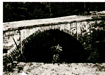
Natursteinbogenbrücke mit 18 m Spannweite und 6 m Pfeilhöhe vor der Sprengung.
