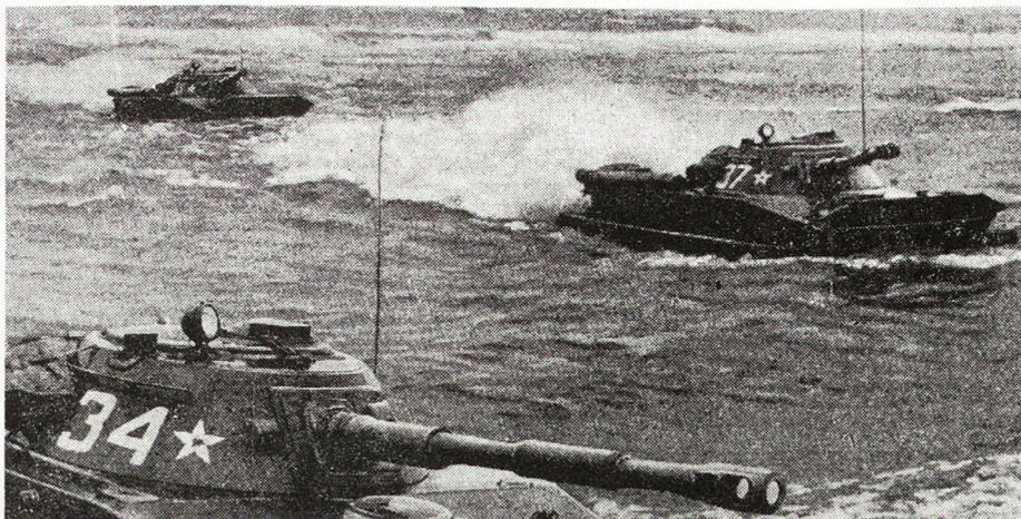
Der schwimmfähige Aufklärungspanzer PT 76 beim Überqueren eines Flußlaufes ...
