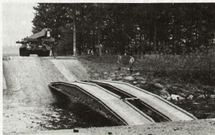
Bild 5. Brücke verlegt, Panzer marschbereit
