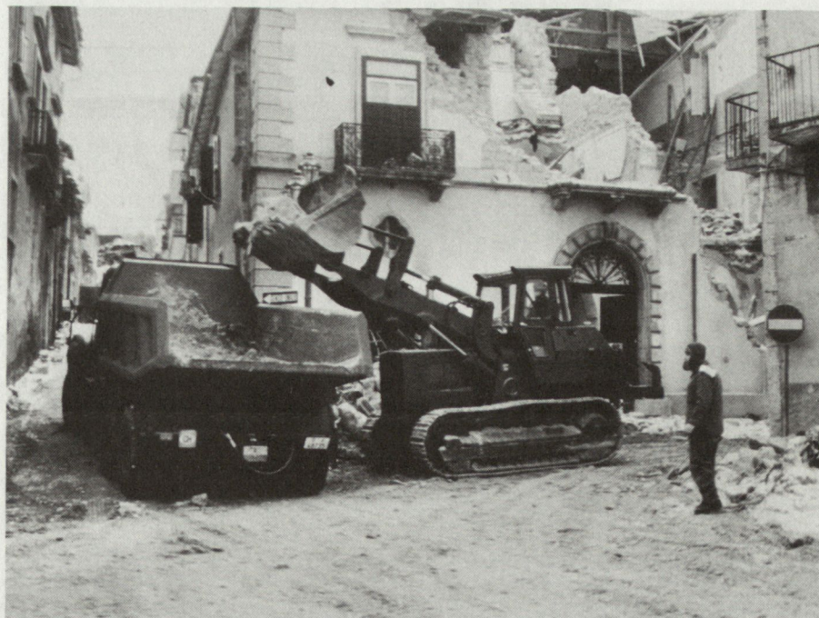
Einsatz von Baumaschinen im Erdbebengebiet Süditalien.
