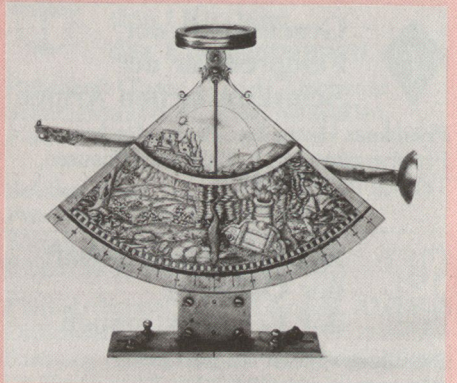
Pendelrichtquadrant mit Bussole (um 1650).
