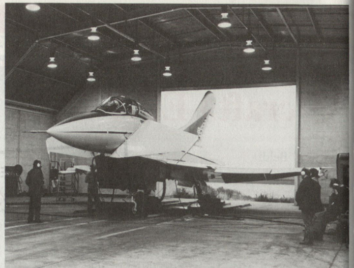
Bild 4: EAP-Versuchsträger beim Systemcheck. Man beachte die grosse Fläche und den hohen Anstellwinkel der Canards.
