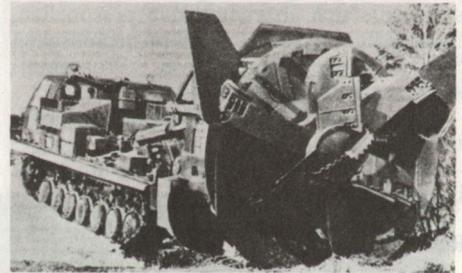
Ebenfalls neu ist der Grabenbagger MDK-3, der mit einem Schaufelbagger von ungefähr 3,8 m Durchmesser ausgerüstet ist. Dieses 30-t-Gefährt besitzt zudem vorne ein rund 3,2 m breites Dozerblatt. Mit dem hydraulisch schwenkbaren Schaufelbagger können Gräben und insbesondere auch Stellungen für Artilleriegeschütze und Raketenysteme ausgehoben werden.
