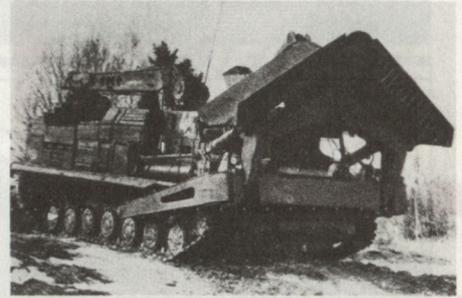
Der neue schwere Bulldozer BAT-2 gilt als Nachfolger des bisherigen BAT. Dieses Geniefahrzeug ist mit einem verstellbaren, max 5m breiten Dozerblatt sowie mit einem Drehkran und Seilwinde ausgerüstet. Der BAT-2 wird innerhalb der sogenannten «Abteilungen zur Sicherstellung der Bewegung» für die Hindernisbeseitigung sowie die Instandstellung und den Unterhalt von Marschstrassen verwendet.
