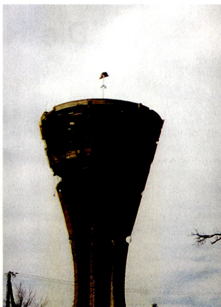
Bewusste Zerstörung der Infrastruktur, hier des Wasserturms.
