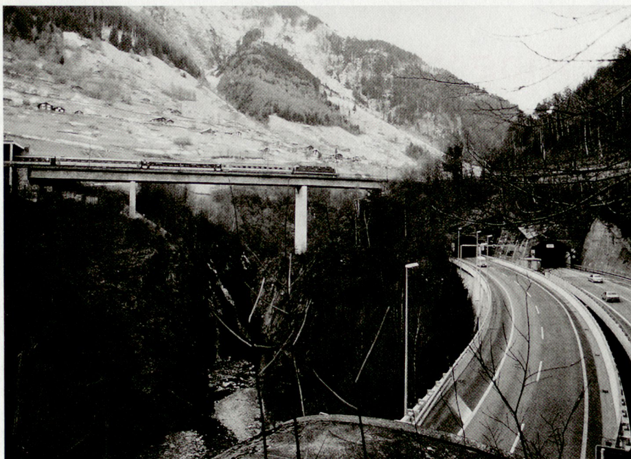
Alpentransversalen müssen besonders geschützt werden. (Aufnahme: Foto-Service SBB)
