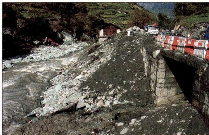
Schadenplatz Neubrücke Nord, die Bahntrasse ist nicht mehr sichtbar. Es befand sich unter dem Schuttkegel und der über die Ufer getretenen Vispa.
