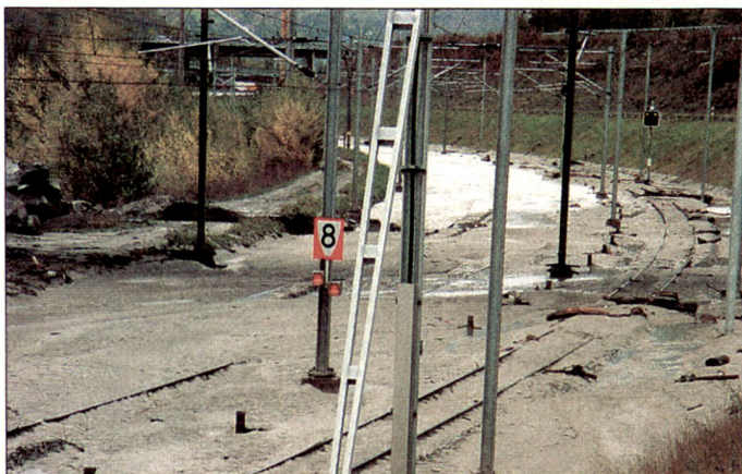
Schadenplatz Gamsen am 16. Oktober 2000.
