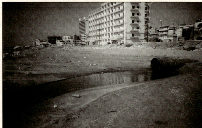
Abwasserrohr ins Mittelmeer (Tartus, Syrien).
