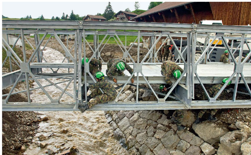
Genietruppen beim Brückenbau.
