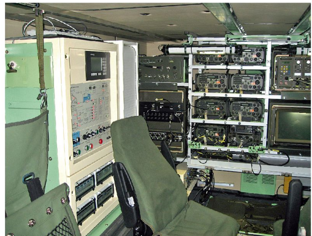
Innenansicht eines Radio Access Point Panzers (RAP Pz): Integration von Telekommunikationsausrüstung auf engstem Raum.
