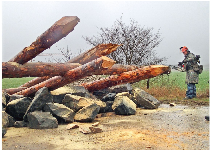
Vorbereitungsarbeiten am Holzhindernis.
