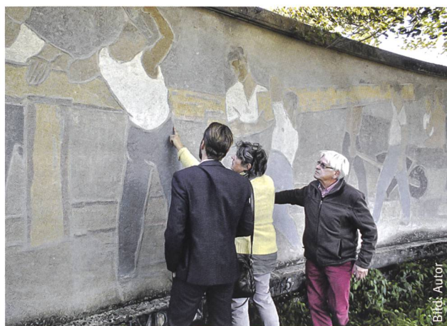
Fachleute bei der Begutachtung der Denkmal-Sanierung.
