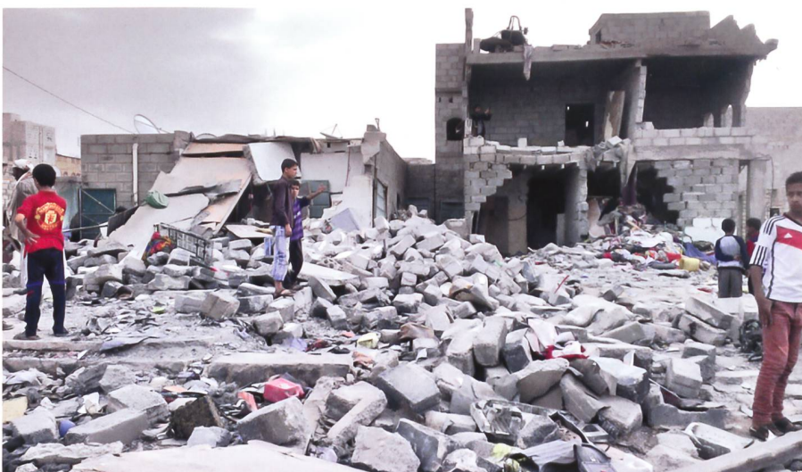
Die Luftschläge der arabischen Koalition legen Jemens Städte und Infrastruktur in Schutt und Asche. Zerstörungen nach einem Luftschlag in Sanaa im Oktober 2015.
