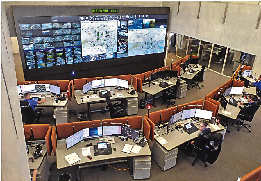
Die Kantonale Notrufzentrale mit dem Arbeitsplatz des COM hinten rechts im Bild.
