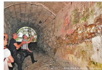
Untersuchung des Majorsgangs von der oberen Plattform der Riedholzschanze in die untere Plattform mit Unterstützung der Denkmalpflege des Kantons Solothurn. Mit modernsten Echlotgeräten soll die Suche nach Quergängen und Kavernen fortgesetzt werden.
